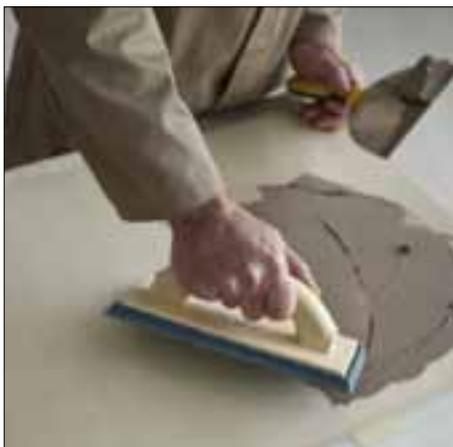
È un materiale eco-compatibile innovativo, con il quale si può realizzare una superficie continua; è il risultato di un'accurata ricerca tecnologica, utilizzabile per pavimenti e rivestimenti, nel totale rispetto dell'ambiente: ignifuga, incombustibile, traspirante, ingeliva, flessibile, resistente ai raggi UV, idrorepellente, riciclabile, priva di cementi, di resine epossidiche e sostanze tossiche per l'uomo e l'ambiente.
